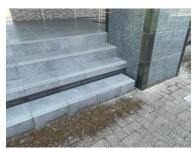
外壁の修復中の建物 地盤沈下による基礎のズレ
