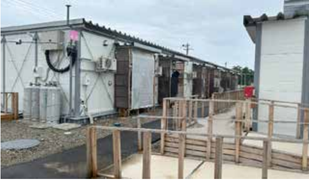
写真 3. 応急仮設住宅（宝立町第 1 団地）
