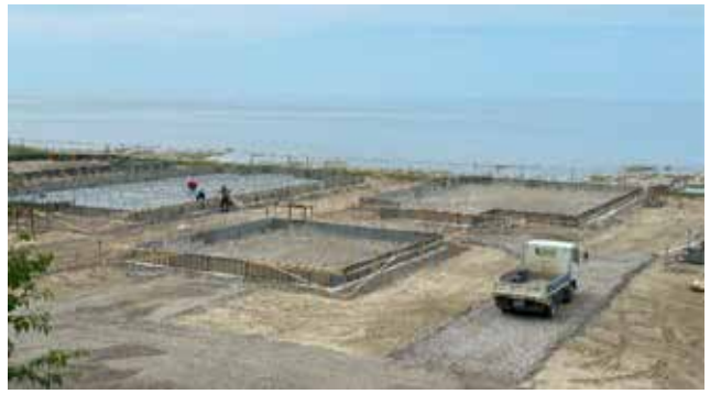
写真 4. 大谷小中学校グラウンドに建設中の応急仮設住宅
